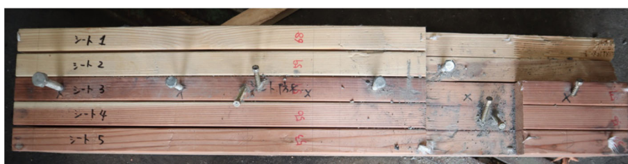
写真 46 解体時の状況（透湿防水シート仕様）
