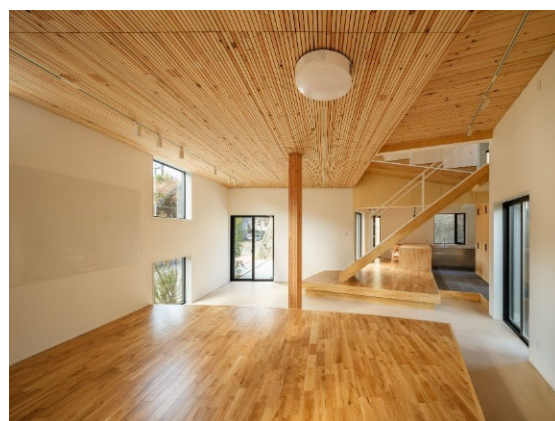
写真 3 DLT活用例 2 (天井)
