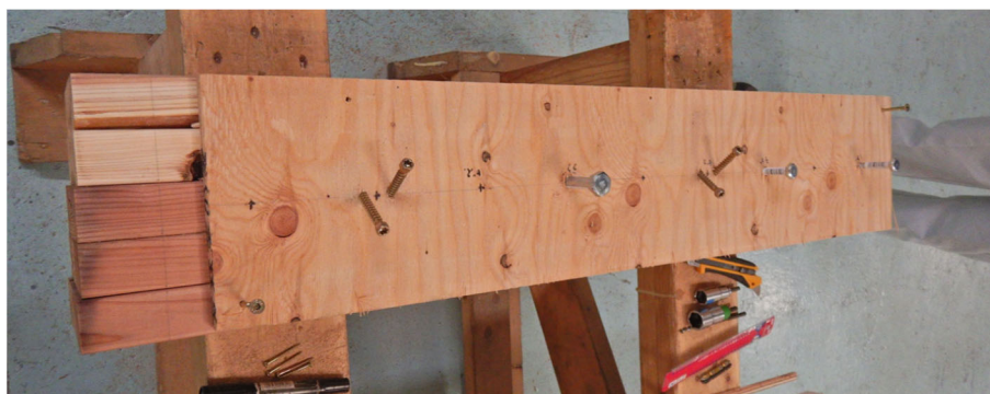
写真 39 接合具の施工状況（合板）
