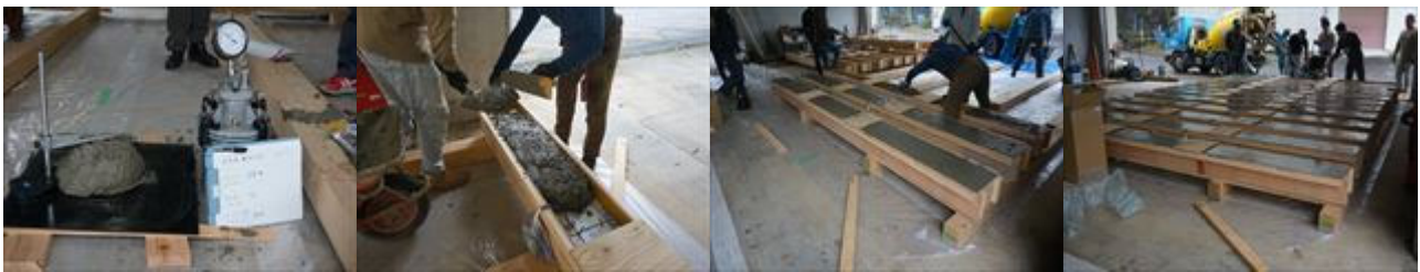
写真 22 コンクリート打設状況
