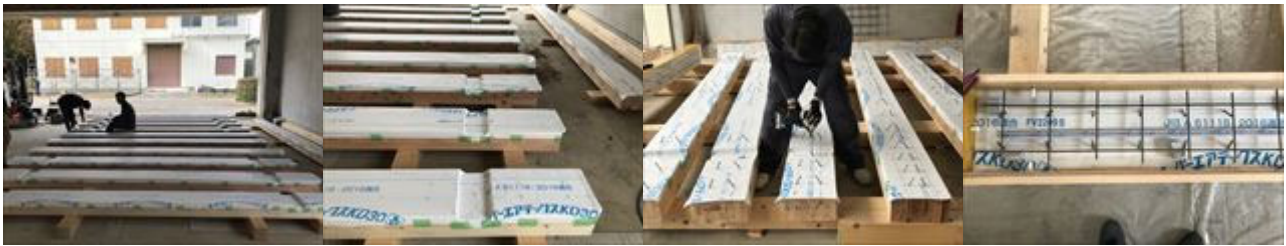
写真 21 試験体製作状況
