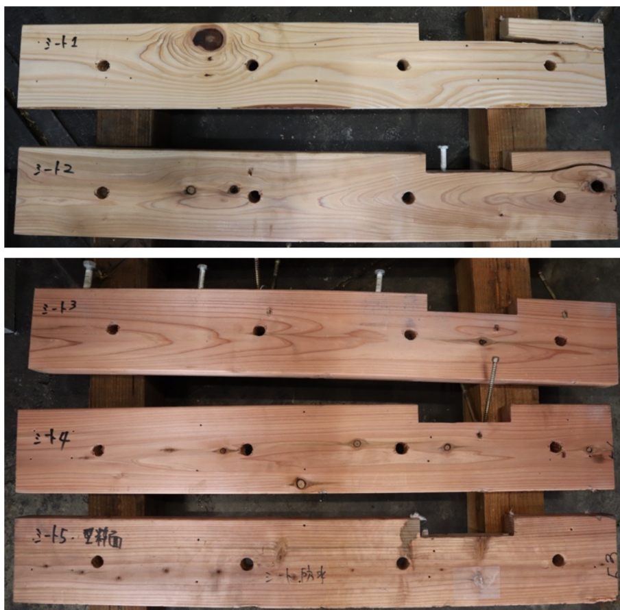
写真 48 解体ラミナの状況（透湿防水シート仕様）
