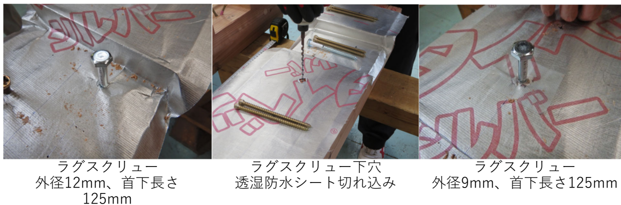
写真 38 接合具の施工状況（透湿防水シート）
