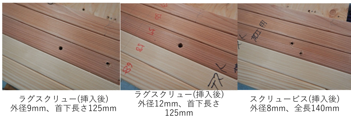
写真 40 接合具の施工状況（合板）
