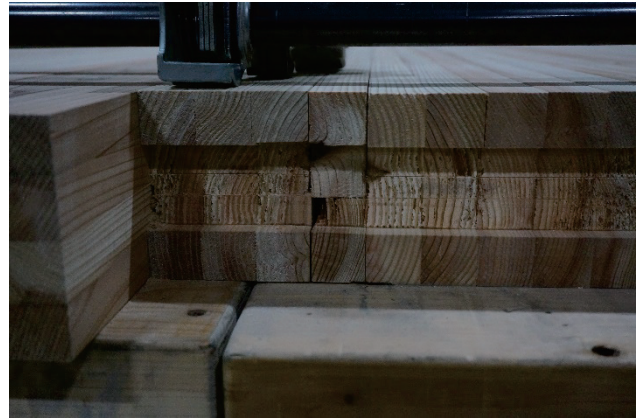
写真 33 柱-補強DLT-DLTパネル 接合部拡大
