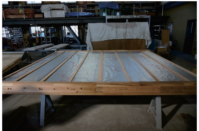
写真 45 壁下地縦胴縁 取付
