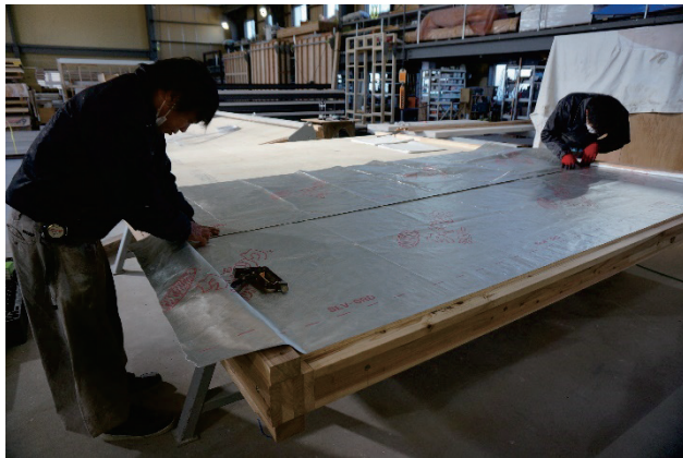
写真 44 壁下地取付 状況
