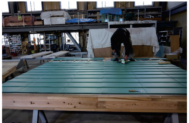
写真 47 金属サイディング取付
