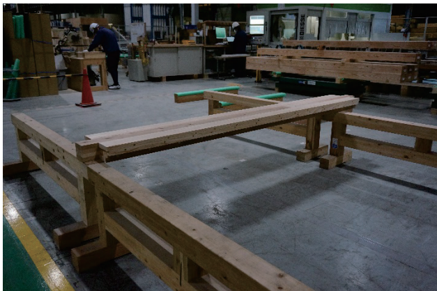
写真 26 試験体組立 (柱 + 座屈補強)
