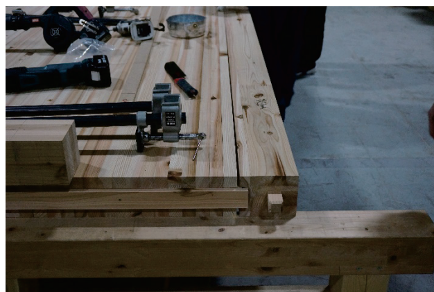
写真 39 柁材－DLTパネル 接合
