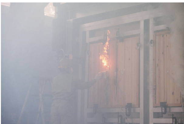
写真 22 火炎貫通部の充填状況
