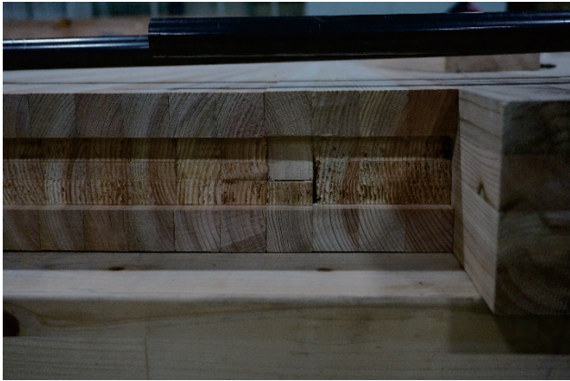
写真 32 柱-補強DLT-DLTパネル 接合部拡大
