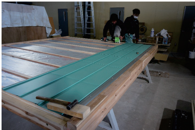
写真 46 金属サイディング取付 状況
