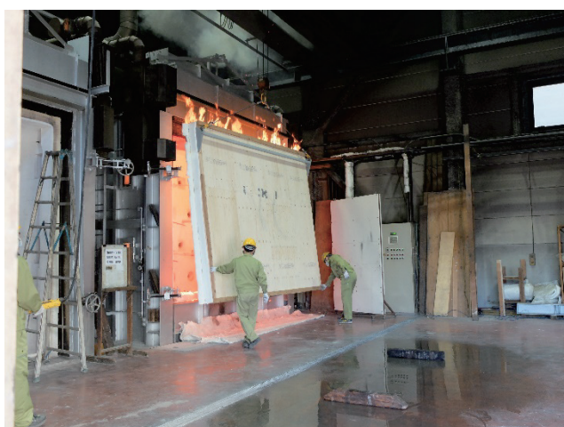
写真 78 試験体B 脱炉
