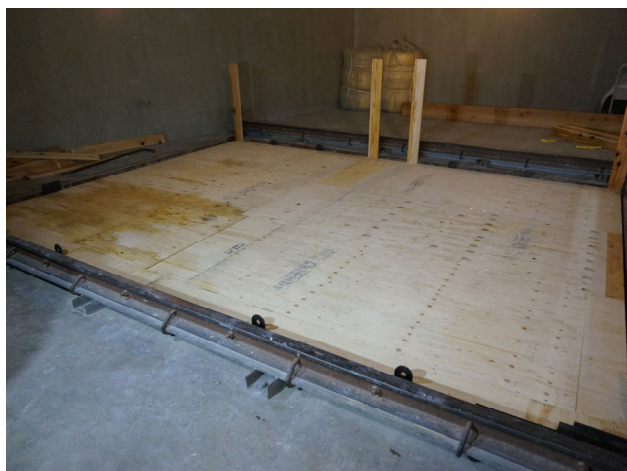
写真 30 試験体 組立状況
