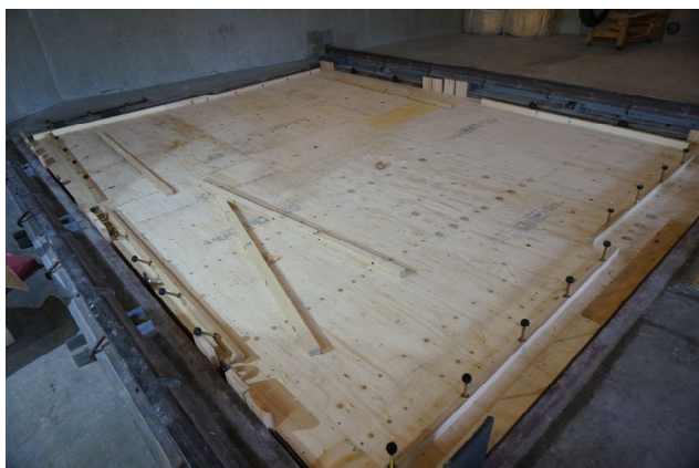
写真 35 2重床設置状況 支持脚
