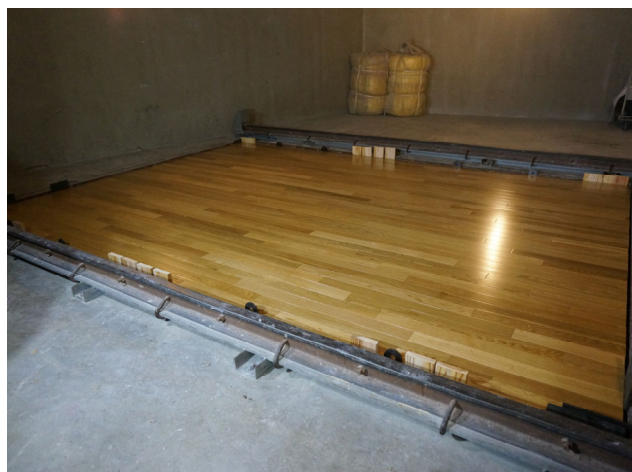
写真 31 試験体 フローリング施工
