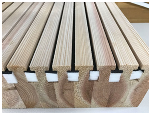
写真4 DLT吸音パネルの断面
