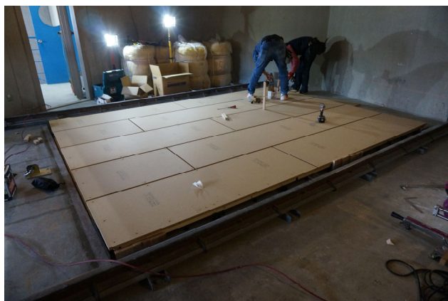
写真 36 2重床設置状況 ベースパネル
