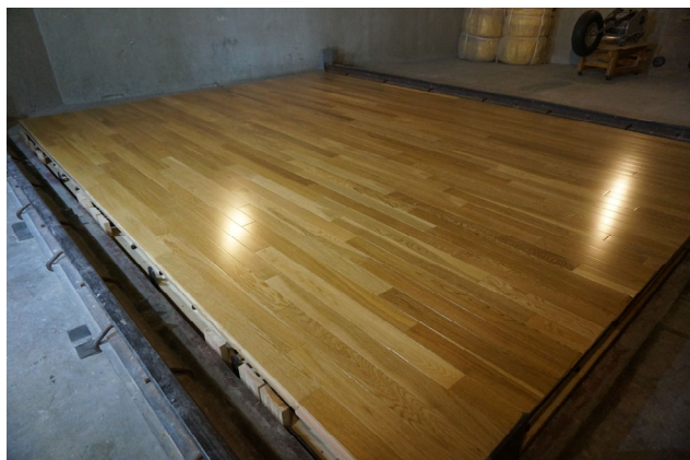
写真 42 2重床設置状況 仕上がり状況
