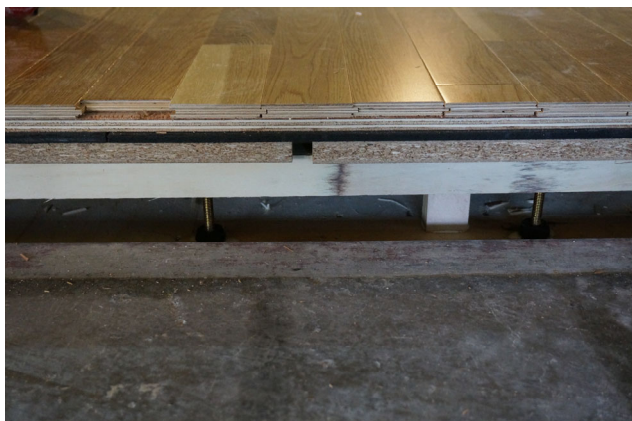
写真 41 2重床設置状況 構成
