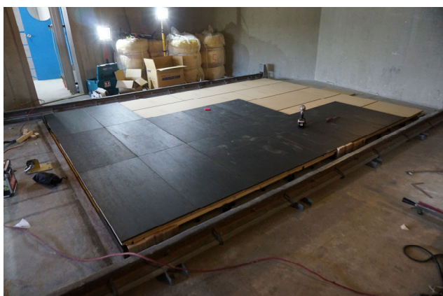
写真 37 2重床設置状況 遮音シート
