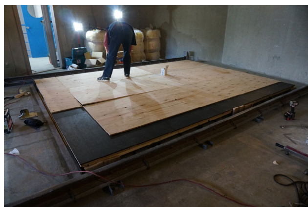
写真 38 2重床設置状況 捨て貼り合板
