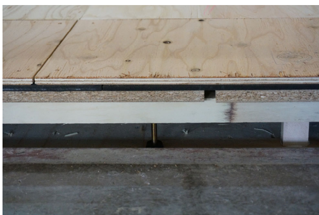
写真 39 2重床設置状況 構成
