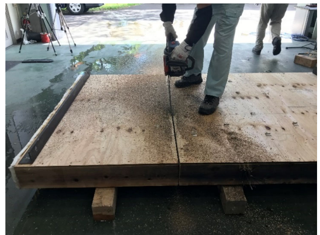
写真 11 試験体A (解体状況)
