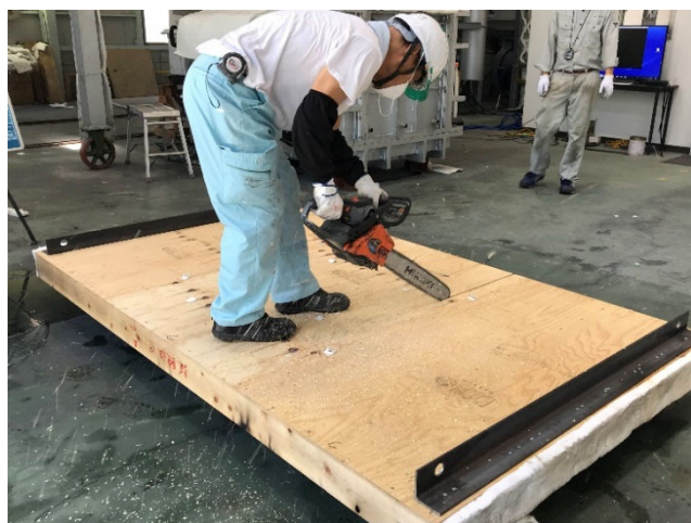
写真 28 試験体C (解体状況)
