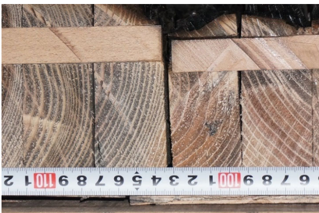
写真 69 残存断面の観察（隙間部分）
