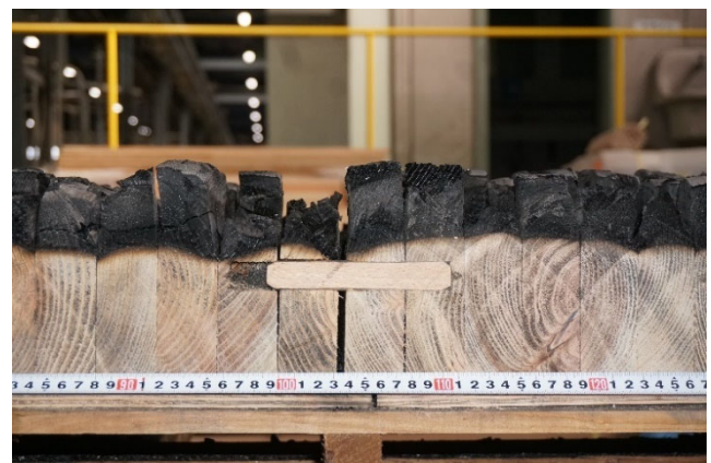
写真 70 残存断面の観察（隙間部分）
