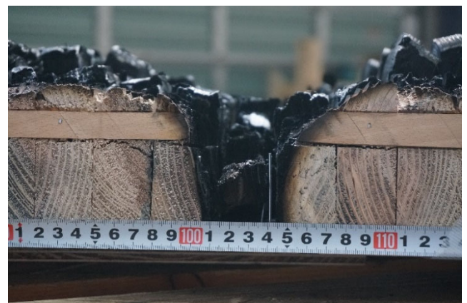
写真 87 残存断面の観察（隙間部分）
