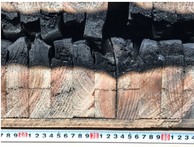
写真 84 残存断面の観察（パネル継ぎ手部）
