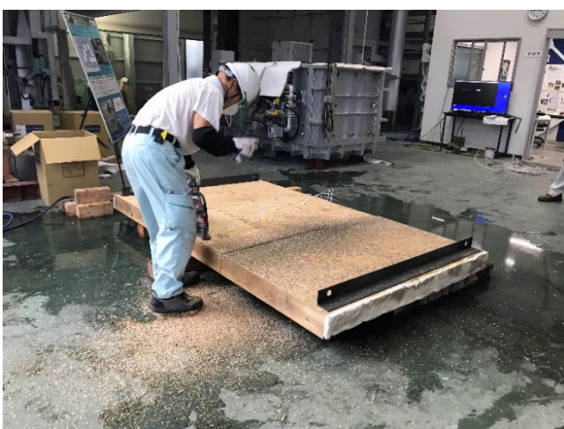
写真 20 試験体B (解体状況)
