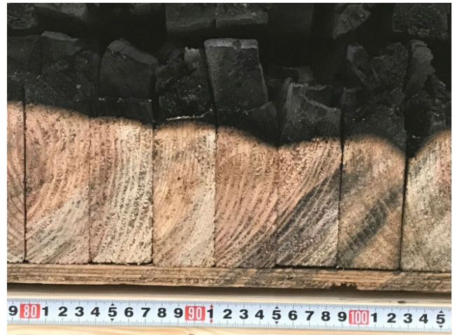
写真 68 残存断面の観察（隙間部分）
