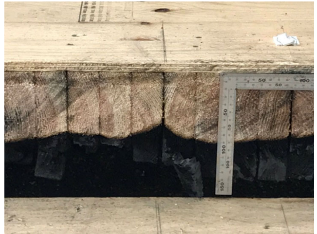
写真 14 試験体A (測定状況)
