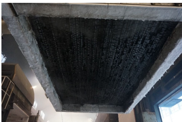
写真 80 脱炉後の加熱面
