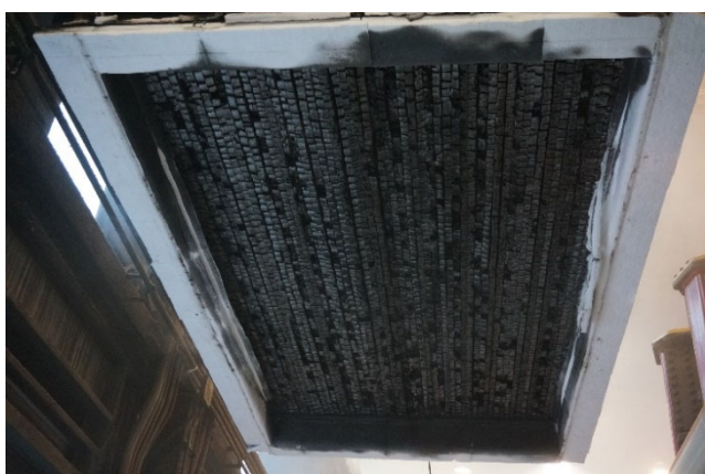
写真 63 脱炉後の加熱面
