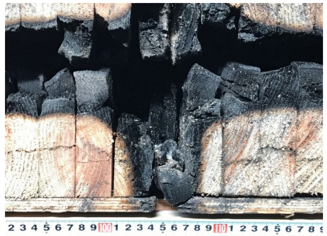
写真 85 残存断面の観察（隙間部分）
