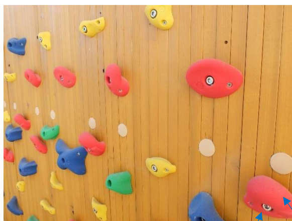
ボルダリングホールド 取付状況
