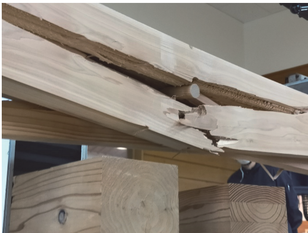
写真 3.2 - 2 試験体 A2-2 曲げ破壊の状況 拡大
