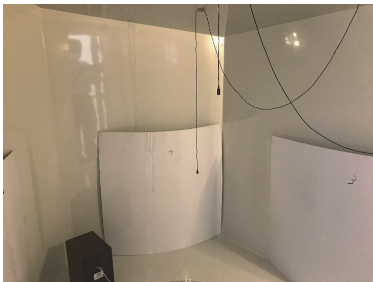
写真 5 - 1 吸音試験室内観
