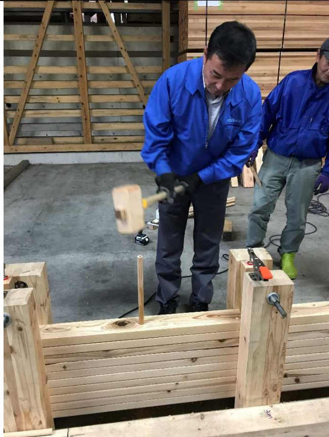
写真-9-9 小井土委員による木ダボ打ち込み
