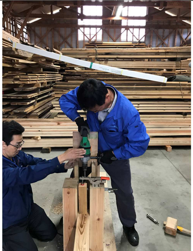
写真-9-6 小井土委員による孔あけ加工
