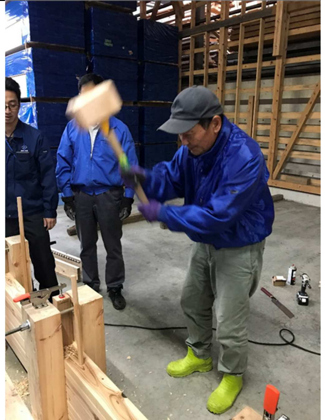
写真-9-10 小井土製材 社員による木ダボ打ち込み
