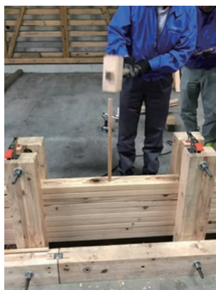
木ダボ打ち込み状況
