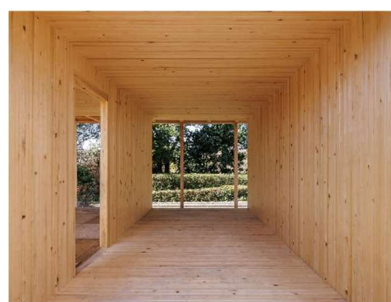
DLT箱型ユニット 内部の様子
