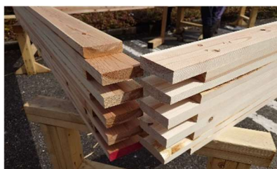
DLTの榫状端部を組合せる様子
