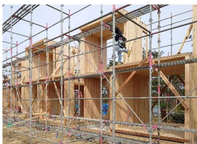
DLT箱型ユニット施工の様子
