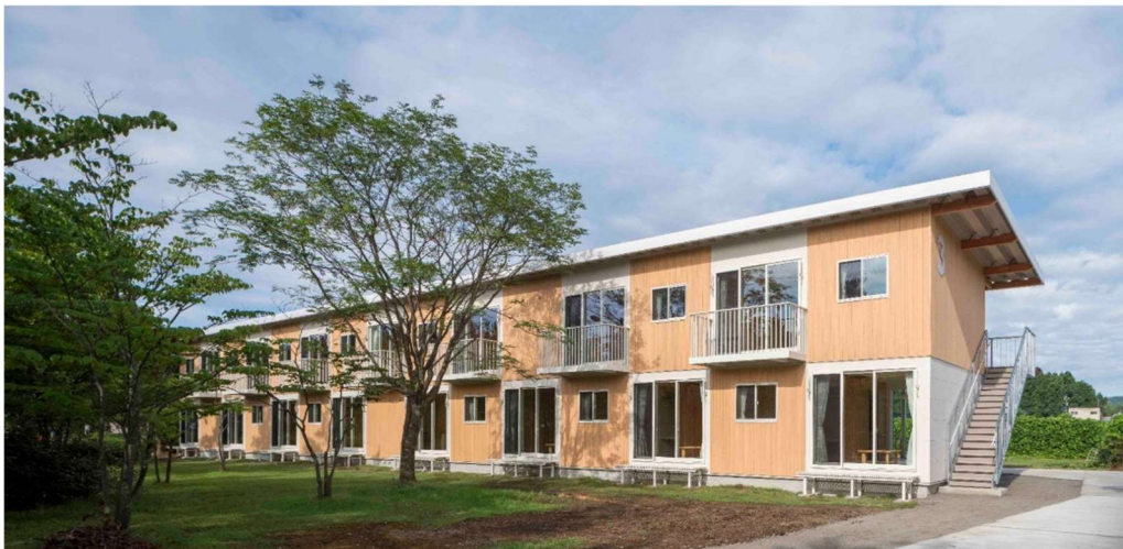
DLT恒久仮設木造住宅 外観
